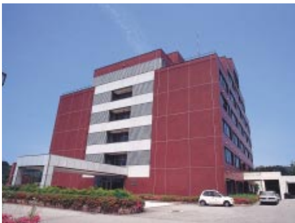
本部, 保健管理センター, 留学生センター Main Office, Health Service Center, International Student Center
