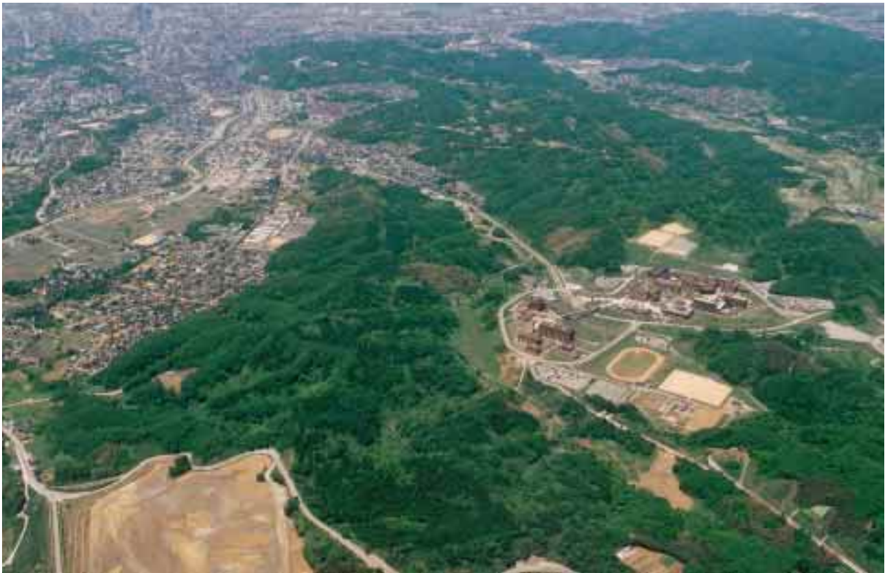
太陽が丘付近上空から卯辰山方向を臨んで(平成9年5月撮影) 総合移転第一期計画事業も無事完成した角間キャンパス(206.7ha)。写真中央左寄りには第一期用地となる緑の丘陵が広がる。
